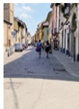
In via Garibaldi la pavimentazione è sconnessa
