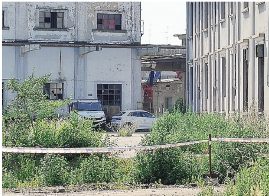
Ruspe al lavoro all'interno dell'ex Consorzio agrario
